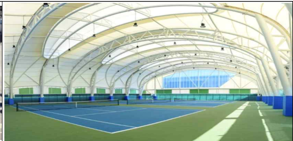
테니스장 막구조물 설치 내부
