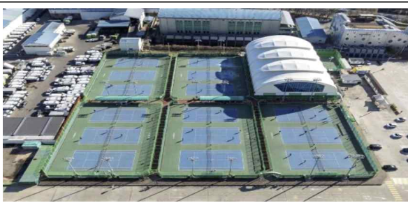
테니스장 막구조물 설치 전경
